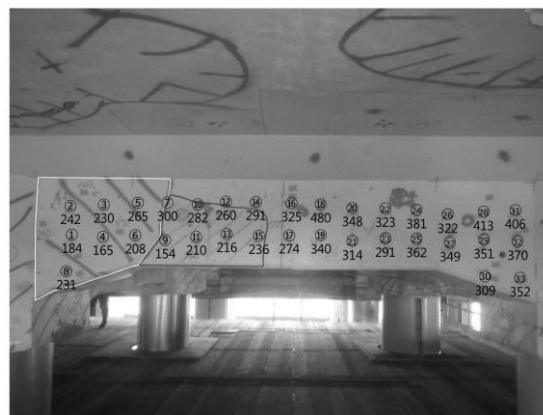
図-15 叩き点検と厚さ評価の結果
