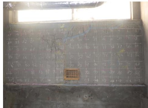
図-12 ボイラ室の壁面
