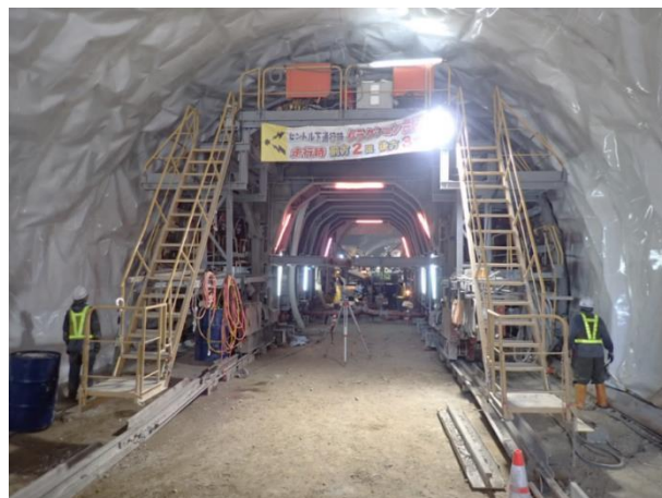
写真-6 コンクリート打込み状況
