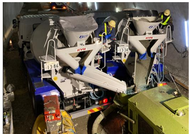
写真-3 コンクリート打込み状況
