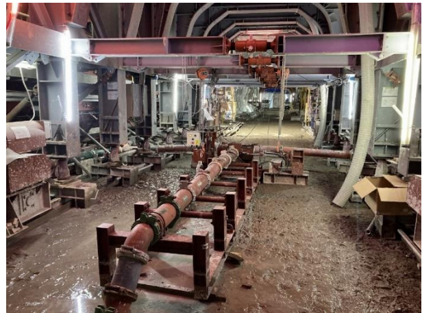
写真-2 スライドセントル内部の状況
