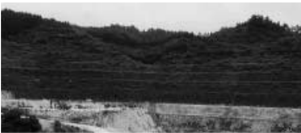
緑化された岩盤斜面／岐阜県 小里川ダム作業所
