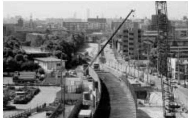
愛知県 JR西名古屋作業所
