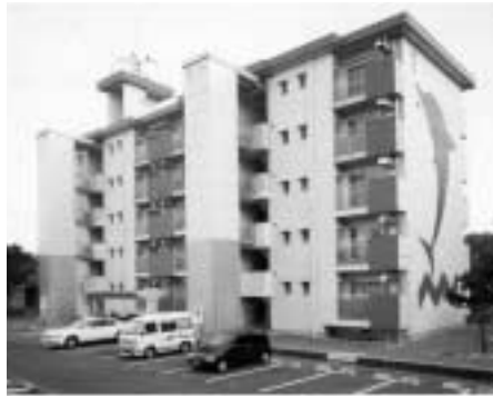
鹿児島県営住宅改善工事
