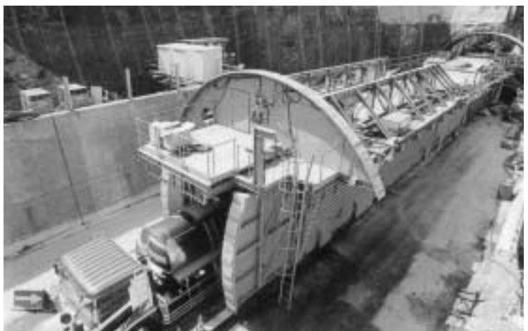
活線拡幅工事/北海道 敷島内トンネル
