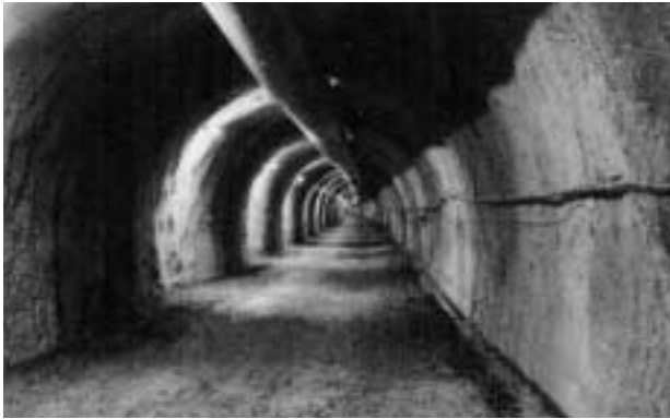
岐阜県 小鳥トンネル作業所
