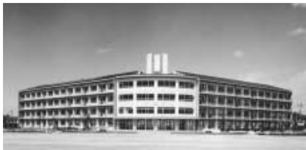
愛知県 丸田小学校作業所
