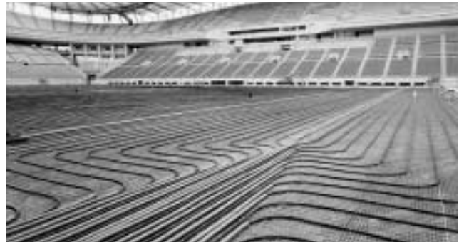
地中埋設管の敷設／カシマサッカースタジアム
