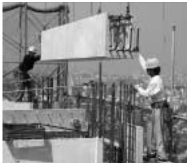
シェルビームの設置状況
