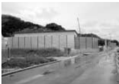
防音壁の設置/高知県 新宇治川トンネル作業所
