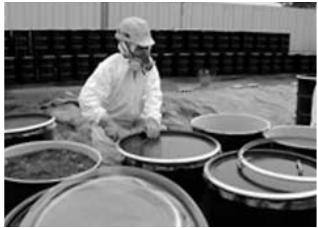
ダイオキシン汚染土壌の密閉作業
