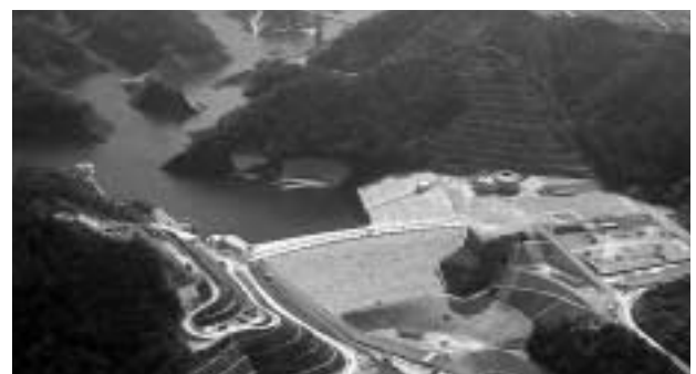
沖縄県 羽地ダム
