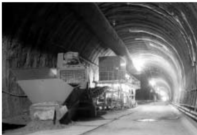
青森県 八甲田作業所
