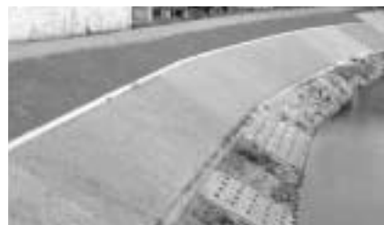
ポーラスコンクリートの施工 ／奈良県 秋篠川
