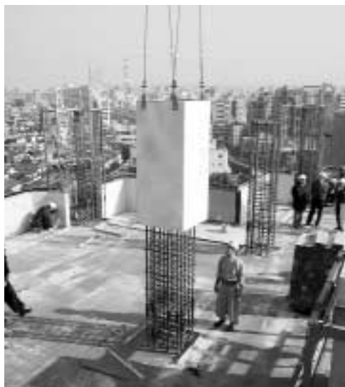
シェルコラムの設置状況
