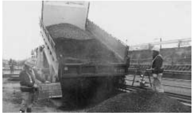
再生碎石の搬入/愛知県 春日作業所
