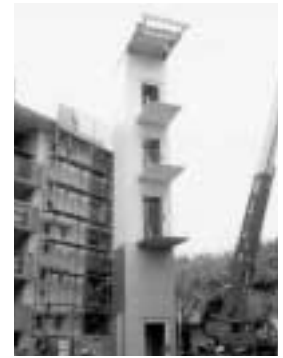
設置工事状況
