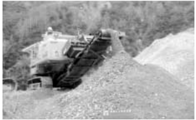
富山県 水谷トンネル作業所
