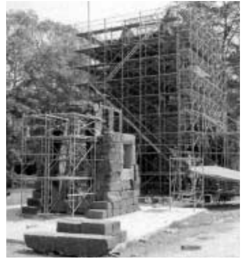
塔の修復作業
