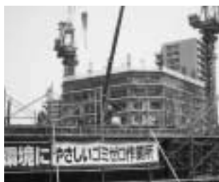
西大井駅前南地区第一種市街地再開発事業施設建築物新築工事
