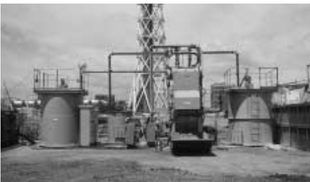
メビウス処理工法プラント
