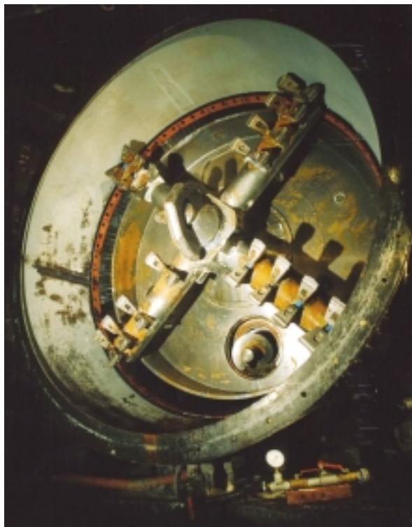
スライドゲートを通過しエントランスに到達したシールドマシン
