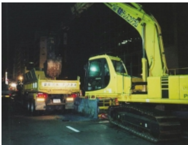
電動式テレスコピックラムシェルによる掘削・積込
