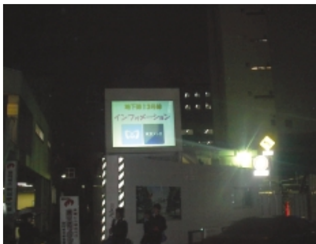
ストリームビジョンによる工事案内
