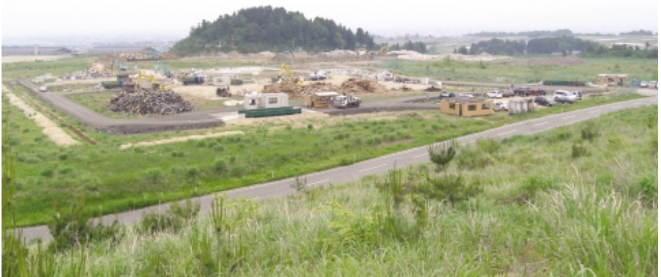
長岡市被災家屋解体廃棄物処理業務
