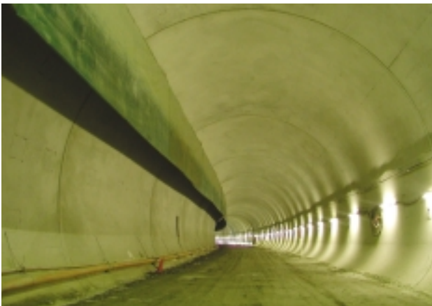
夕張シューパロダム道道付替1号トンネル
