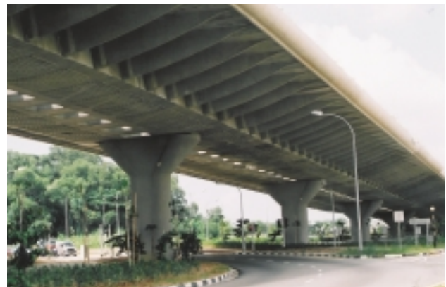
タンピニス高架橋
