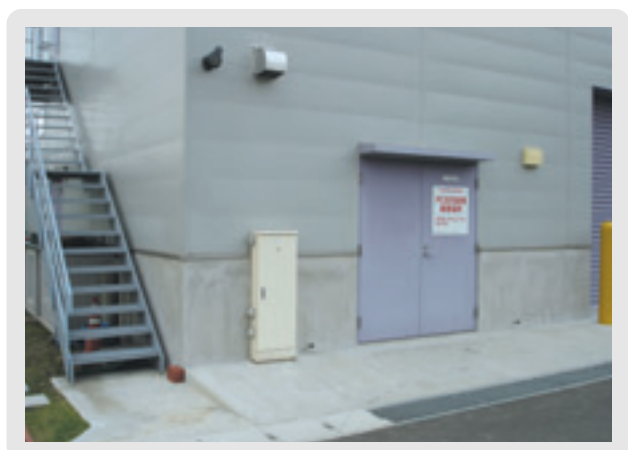
技術研究所内 PCB保管倉庫
