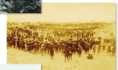
常願寺川改修工事( 明治25年 )
