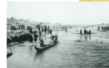
庄川護岸工事( 明治33年 )
