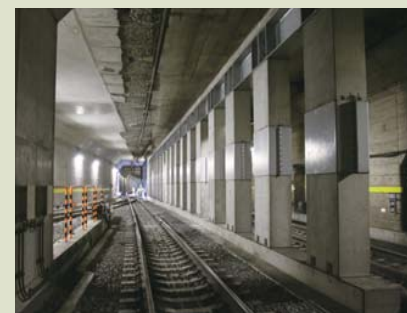
連絡線軌道内全景(A線)
