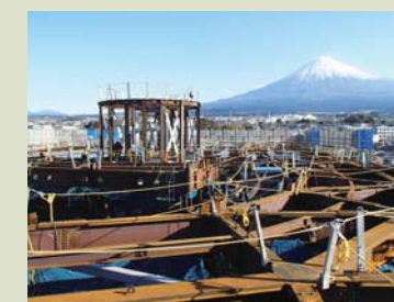
建設中の展示棟 最上部から富士山を望む
