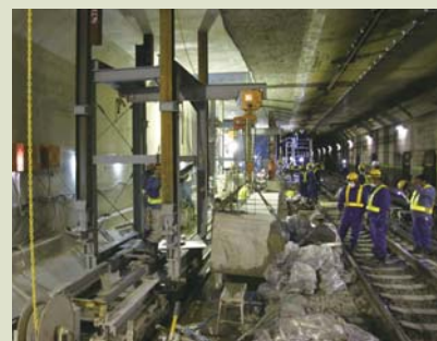
軌道内における既設建築物撤去
